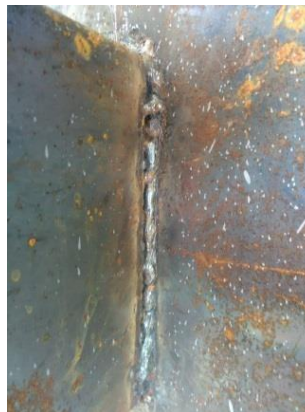
Fotografía 13, 14, 15 y 16. Reparación de soldaduras en cercha metálica acceso a sendero
