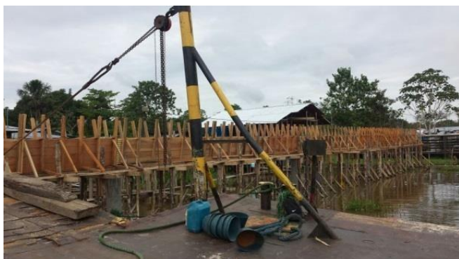
Fotografías 9, 10, 11 y 12. Armada y fundida de viga, tramo sector calle 13
