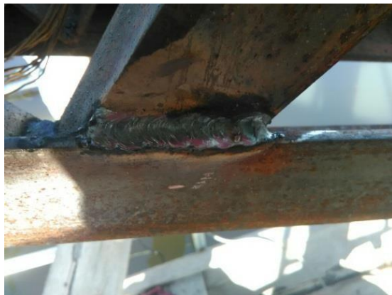
Fotografía 13, 14, 15 y 16. Reparación de soldaduras en cercha metálica acceso a sendero
