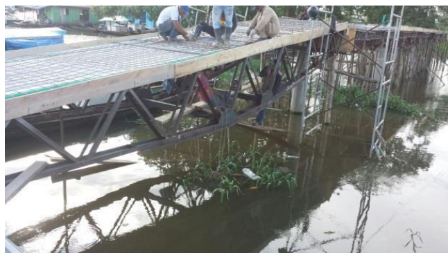
Fotografías 3 y 4. Fundida de la primera sección de placa – amarre de hierro para la placa
